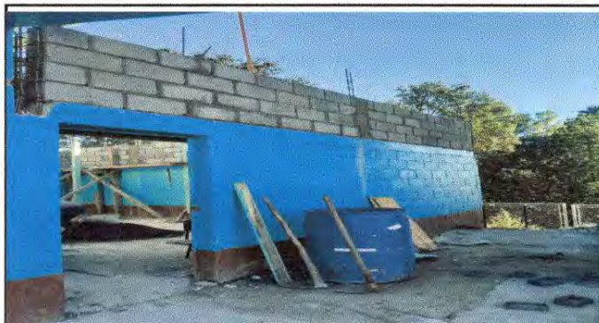
Foto 3: Sustitución de puerta.
