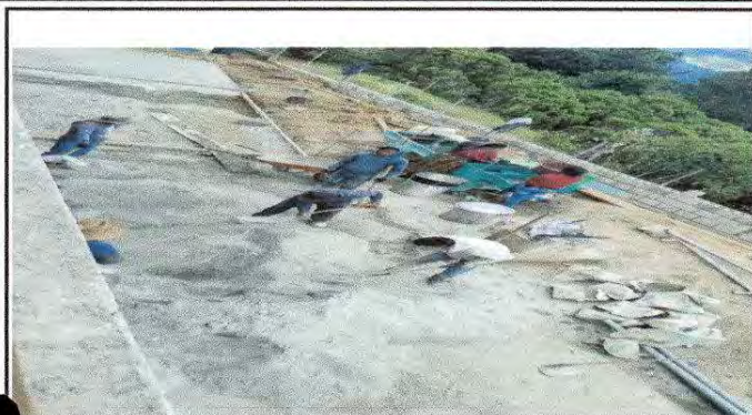
Foto 7: Losa de patio
