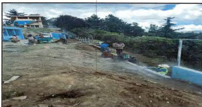
Foto 6: Reparación de muro perimetral de block
