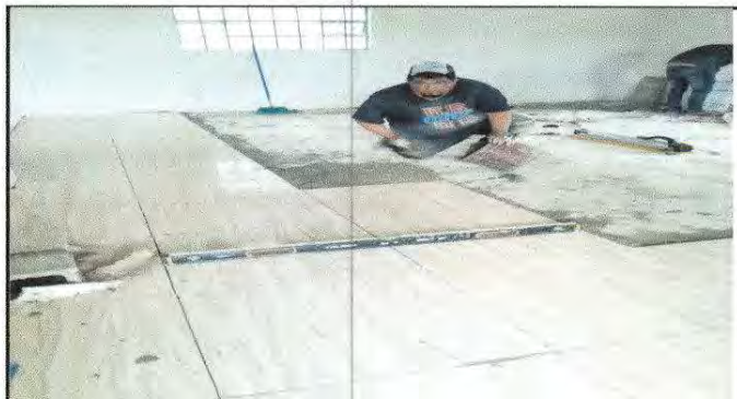
Foto 4: Sustitución de piso de torta de concreto por porcelanato
